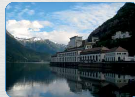
Kraftwerk Tyssedal (N)
